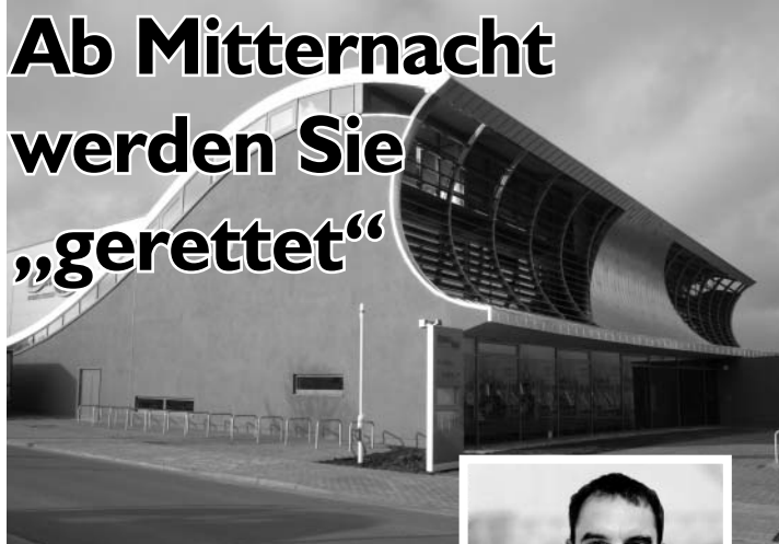
Äußerlich ist das Gebäude fertig, aber innen wird noch fieberhaft gearbeitet ...
