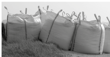
Aus Sturmflutschutz wird Badstrand: Der Sand aus den Big-Packs wird über den Strand verteilt
